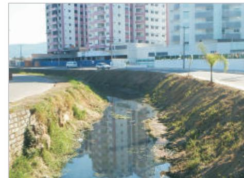
Figura 93: Canal retificado na Bacia Hidrográfica do Rio Itacorubi
