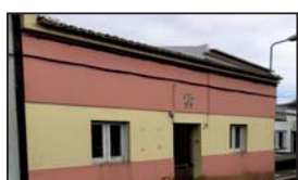
REF 914 Moradia T3 na Faja de cima, a necessitar de obras.
