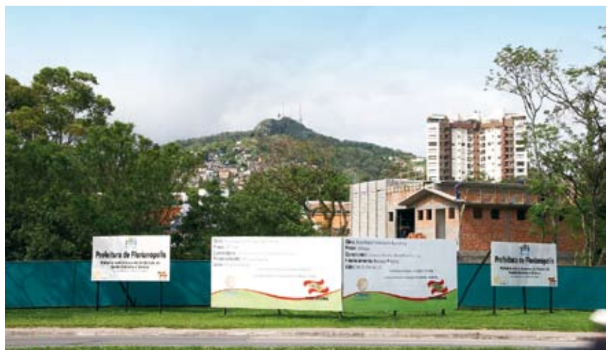
Já está previsto investimento de R$ 75 mi em obras como a subestação Agrônômica
